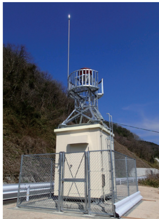
ALC局舎(鉄塔搭載型) W2000×D1800
