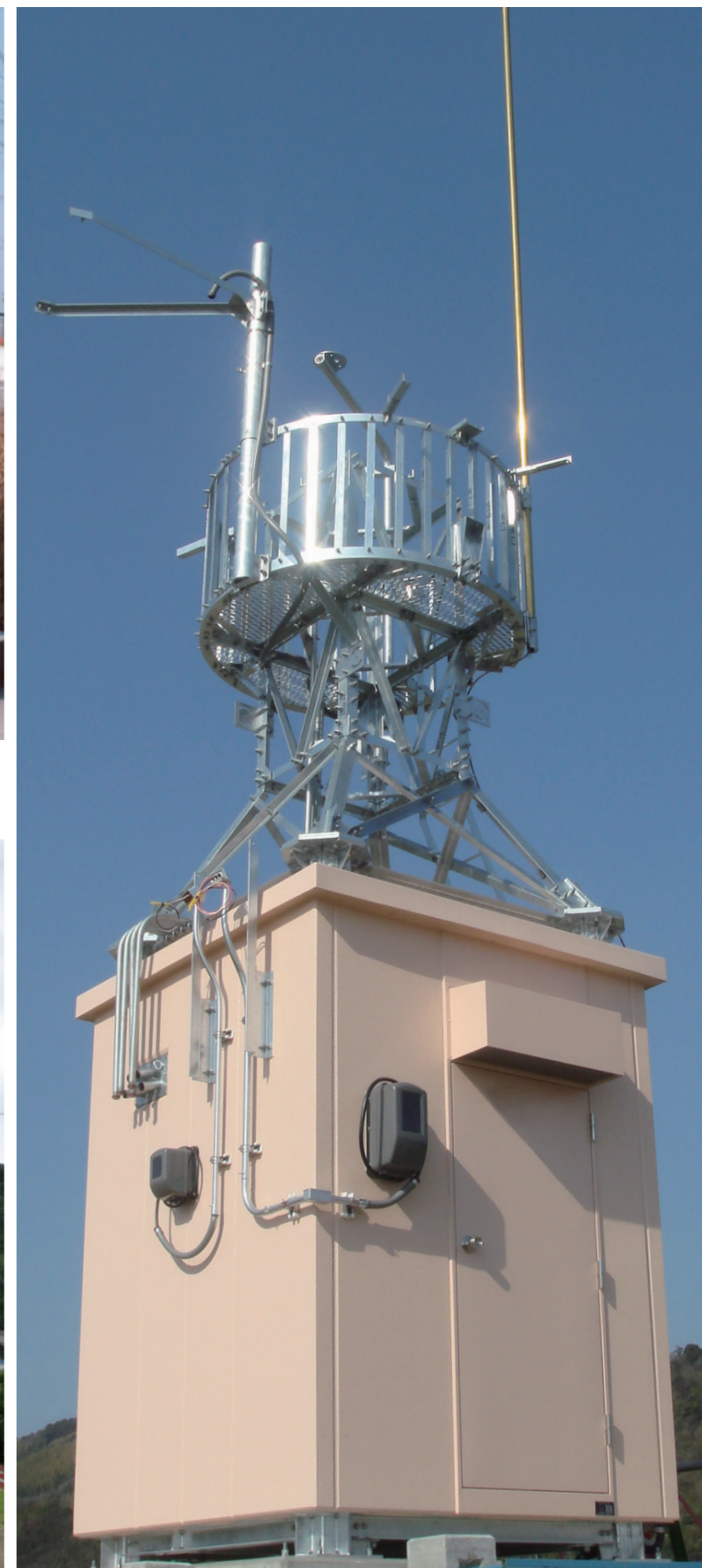
ALC局舎(鉄塔搭載型) W2000×D1800
