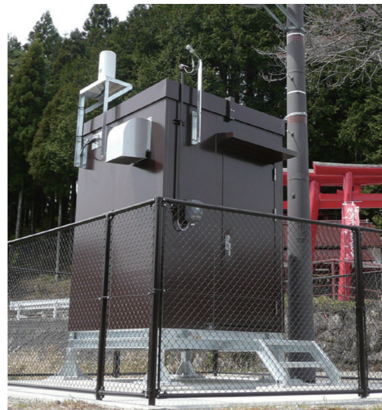
鋼板サンドイッチパネル局舎 W2000×D1800
