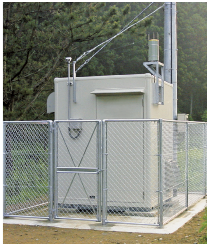
アルミサンドイッチパネル局舎 W2000×D1800
