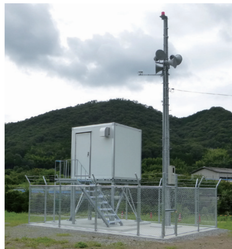
アルミサンドイッチパネル局舎 W2600×D2300
