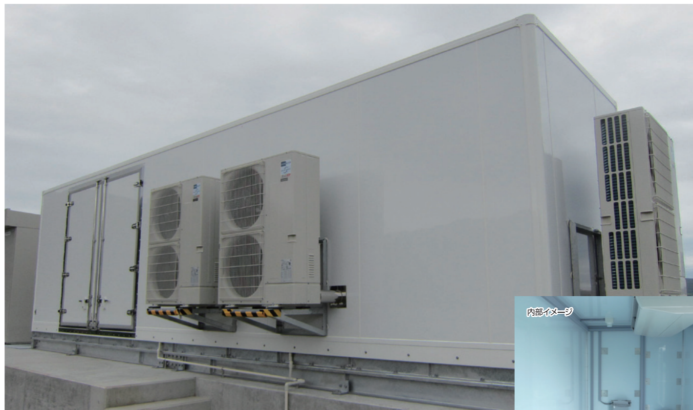
アルミサンドイッチパネル局舎(大型) W9500×D2300
