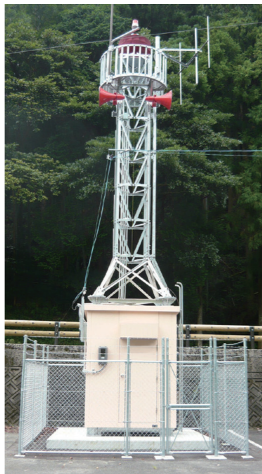
ALC局舎(鉄塔搭載型) W2000×D2400
